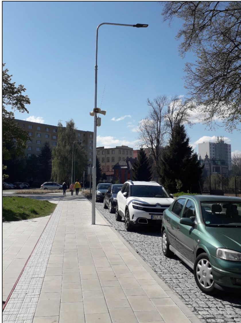
Veřejné osvětlení u. Pražská
